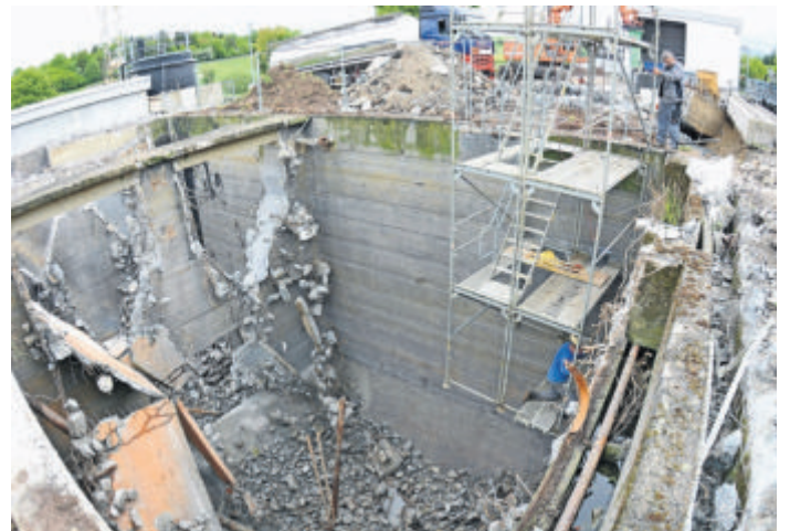
Abrissarbeiten an der Kläranlage
