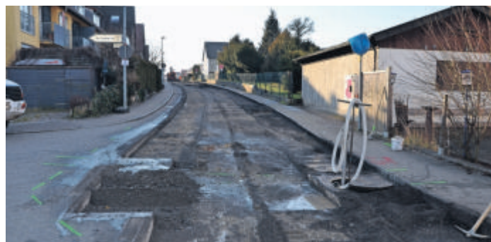
Die Schulstraße vor Beginn der Tiefbaumaßnahme
