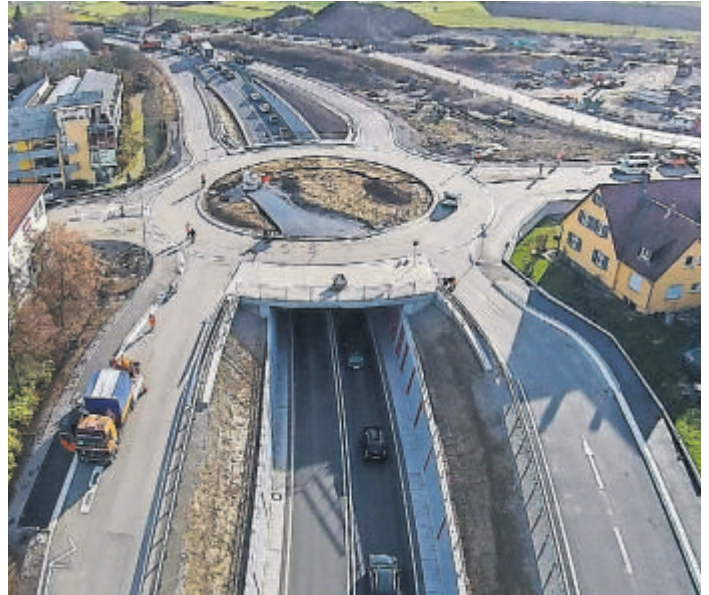
Der Kreisel nach Fertigstellung
