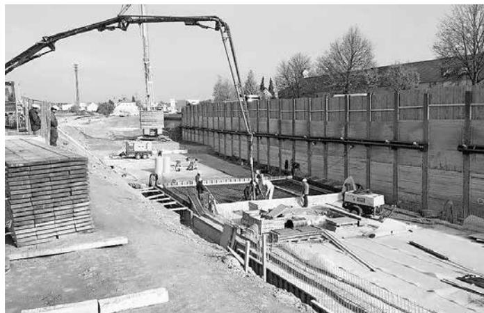
An der Altdorfer Kreuzung wird die Unterführung vorbereitet, hinter der Absperrwand fahren die Autos vorbei.
