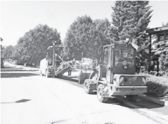
Begonnen wurde mit der Sanierung in der Würmstraße. Hier wurde unter anderem auch die im Laufe der Jahre aufgebrochene Mittel-nahtrasse der Fahrbahn abgefräst und mit einem Dünn-schichtbelag repariert.
