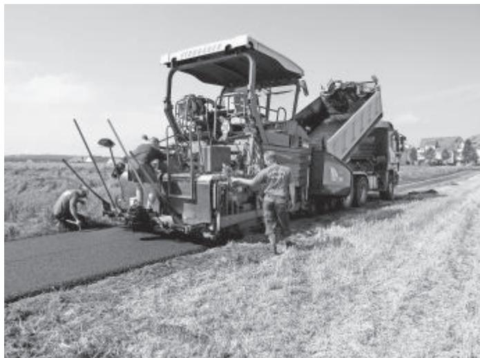
Der Feldweg in Verlängerung des Furtweges beim Einbau der Asphaltsschicht.
