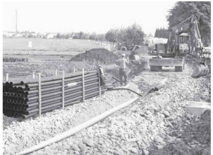
Die ENBW nutze die Maßnahme, um Strom und Gasleitungen zu verlegen. Die Gemeinde verlegte in diesem Zusammenhang ein 3-fach Leerrohr, um ggf. für eine mögliche zukünftige Verkabelung gewappnet zu sein.
