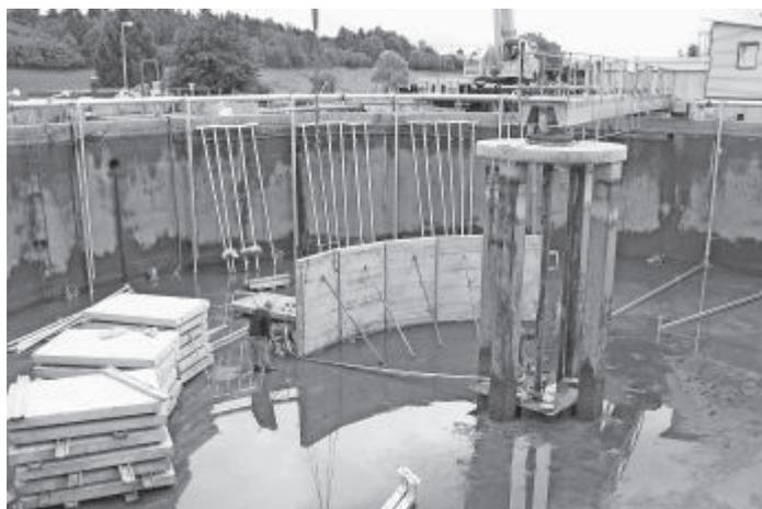
*Die Umsetzung der Sanierungsmaßnahme war nicht ganz einfach, da man zum einen das Belebungsbecken komplett entleeren, aber gleichzeitig der Reinigungsablauf der Anlage weitlaufen musste.*
