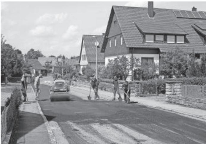
Die "Schlaglochpiste Nr. 1" in Altdorf, unserer Schulstraße wurde abschnittsweise mittels Dünn-schichtbelag repariert. Die Arbeiten waren aus verkehrssicherungsgründen notwendig, obwohl die Straße in den nächsten 1 bis 2 Jahren (einschließlich Wasser-leitungen und Kanal) grundlegend saniert werden soll.
