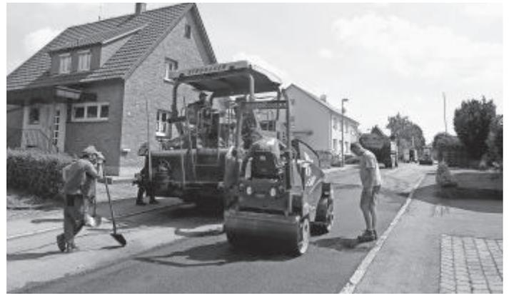
Hier wird der Dünn-schichtbelag eingewalzt.
