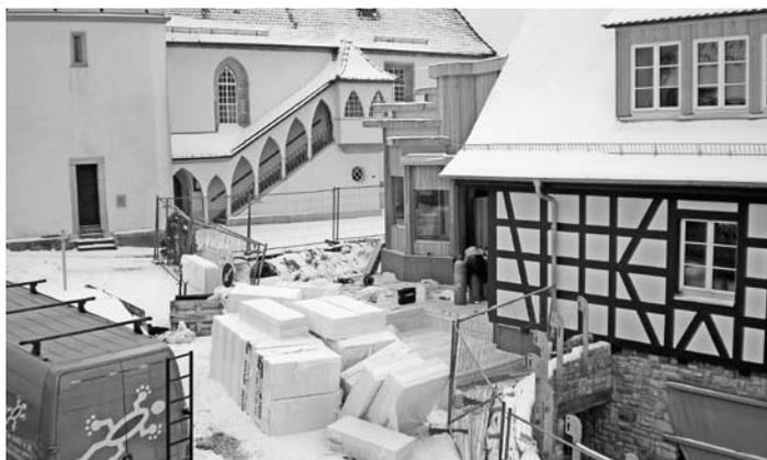
Im Januar wurden Isolierungs- und Abdichtungsarbeiten für das Untergeschoss vorgenommen
