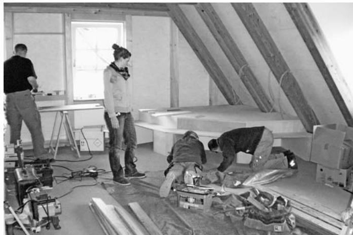
Eine Vielzahl an Innenausbauarbeiten war noch zu leisten - hier der Einbau eines Podestes im Bereich der Bücherei
