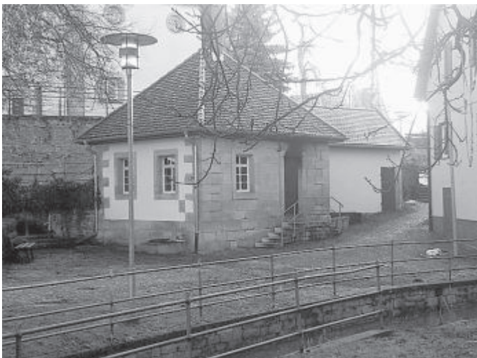
Das Backhaus am Nanteuiler Platz nach seiner Sanierung.
