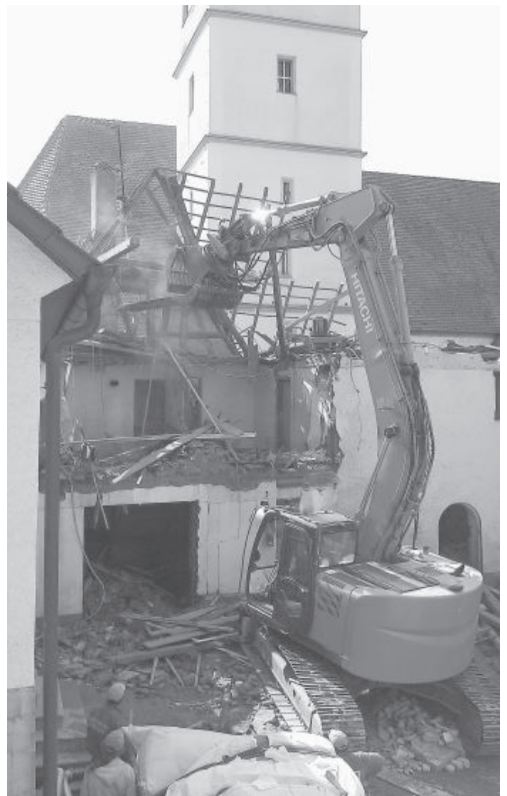
Der Abbruch ging recht schnell von statten.
