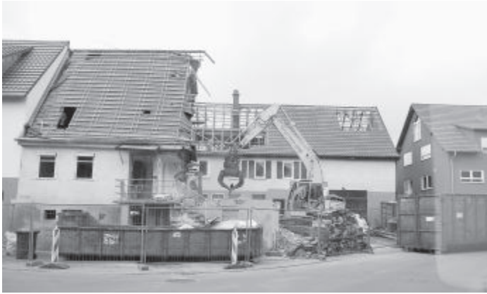
Noch im März sind die Abbruchmaschinen angerückt, um das Areal frei zu räumen.
