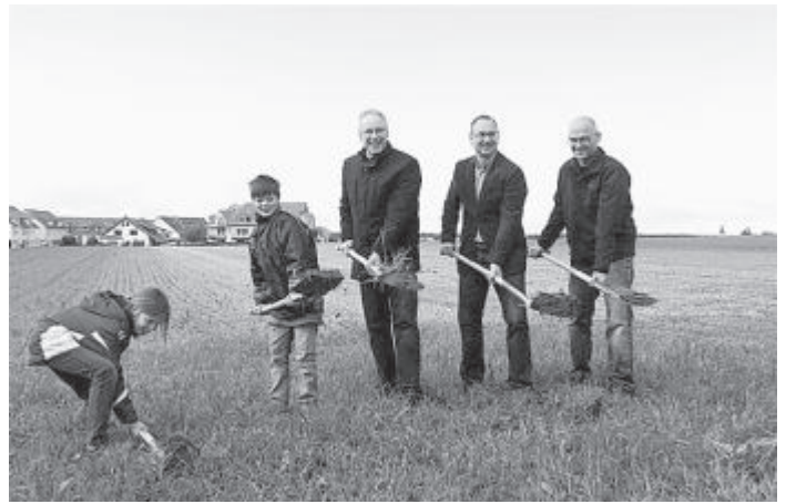
Erster Spatenstich am Altdorfer Ortsrand für das Baugebiet "Bühl I", (v.l.n.r.) Sonia Walsdorff, Jonathan Hermann, Bürgermeister Erwin Heller, Manfred Mezger (Büro mquadrat, Bad Boll), Mark Mayer (Ingenieurbüro Mayer, Böblingen).
