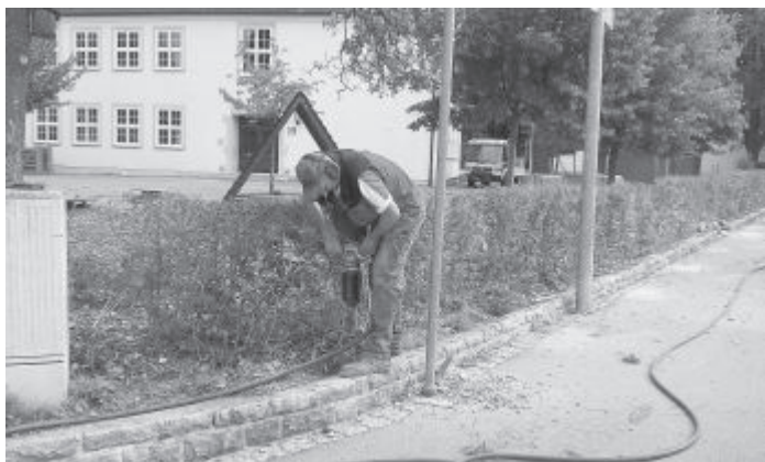
Der stark in die Jahre gekommene Zaun am Schulgelände der Adolf-Rehn-Schule wurde zurückgebaut und durch einen stabilen Stabgitterzaun ersetzt.
