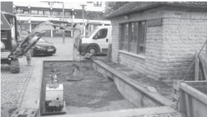
Die Bodenwaage vor dem "Waaghäusle" wurde aus Verkehrssicherungsgründen ausgebaut und die Grube verfüllt.
