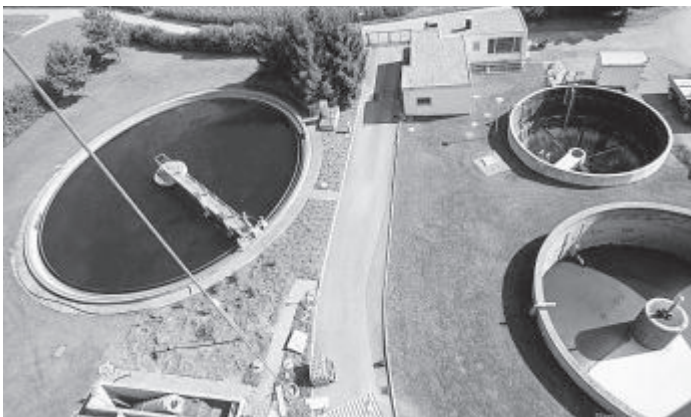
Die Kläranlage "Würmursprung"; Foto: Gemeinde Hildrizhausen
