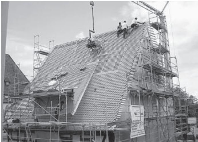
Dachdecker am Werk.
