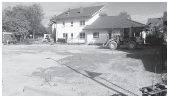
Zu Beginn der Baumaßnahme.
