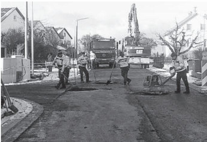
Noch vor der Winterpause wurde die Asphalttragschicht so weit wie möglich eingebaut.
