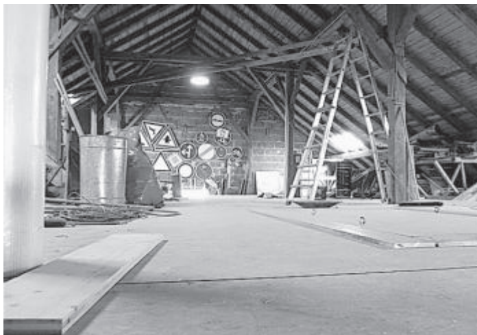
Blick in das Obergeschoss im Bauhofgebäude noch während der Arbeiten.
