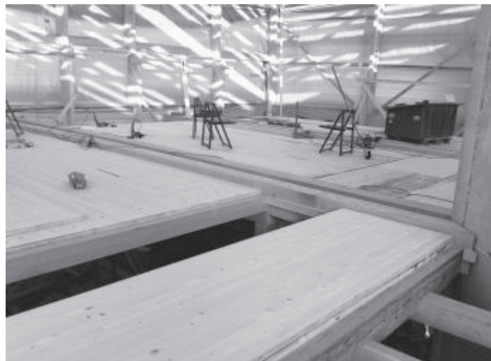
Blick ins „Innere“ - die nächste Decke wird eingebaut.
