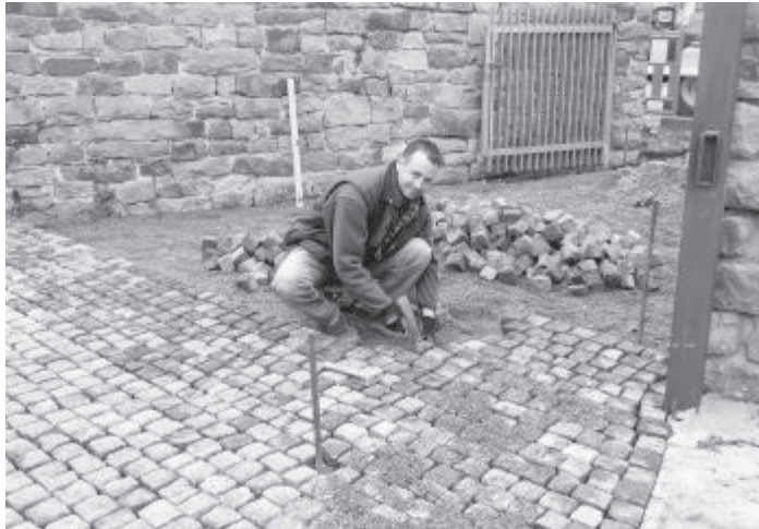
Pflasterarbeiten am Friedhof.
