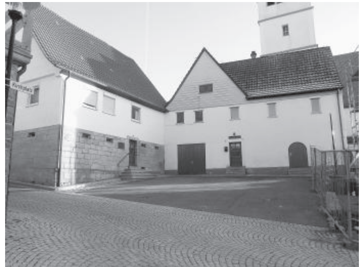
Das Gebäude Kirchplatz 3 vor dem Abbruch.
