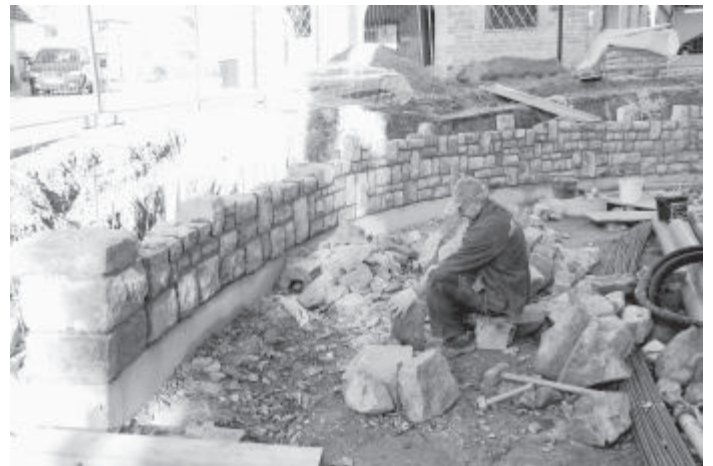
Die Arbeiten am Tiefhof sind gut vorangeschritten und die Natursteinmauer nahm rasch Gestalt an.
