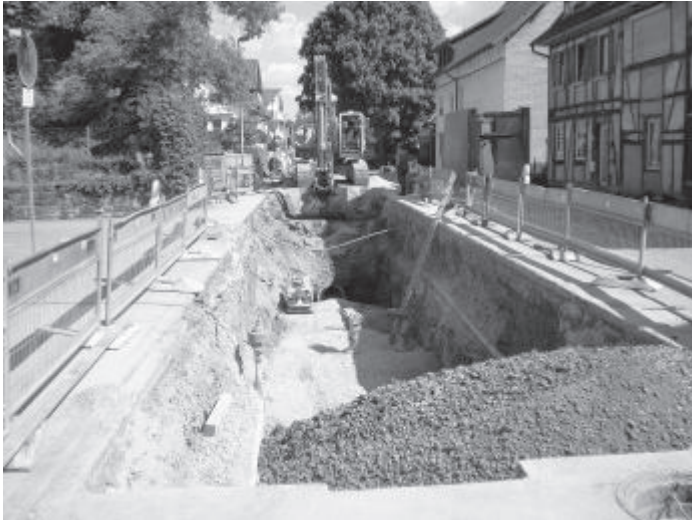
Erster Bauabschnitt in der Schaichhofstraße
