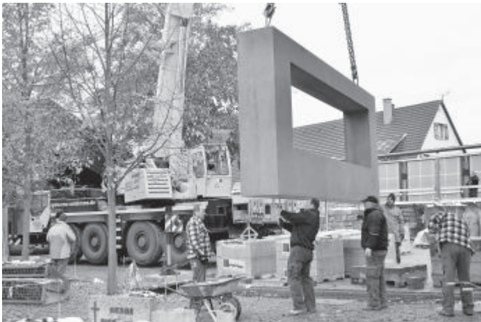
Zum Aufstellen der Urnenwand wurde ein Schwerlastkran eingesetzt.
