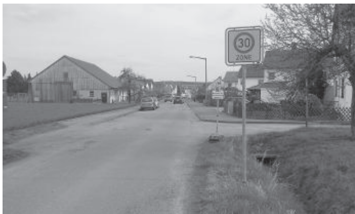
Die Maurener Straße im nördlichen Bereich vor Beginn der Tiefbaumaßnahme.
