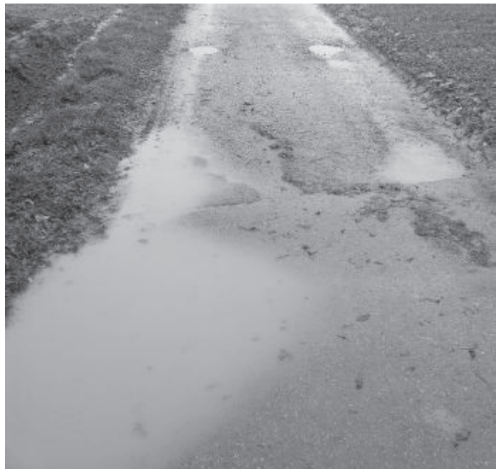
Die ersten Meter des Feldweges glichen einer Schlaglochpiste. Auch dieser Bereich wurde im Zuge der Maßnahme kostengünstig saniert.
