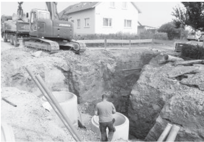
Die Baustelle im nördlichen Abschnitt (Herbst 2012). Mit diesem Abschnitt (Taubenstraße bis ans Ortsende) konnte im September begonnen werden.
