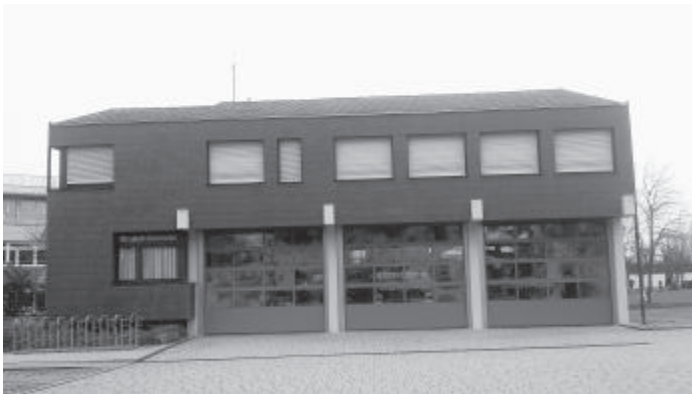
Das Feuerwehrgerätehaus nach dem Einbau der neuen Sectional-Tore.
