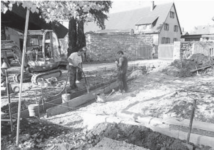
Arbeiten am Lagerplatz.
