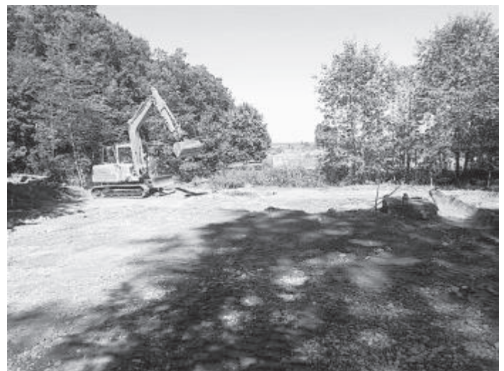
Zunächst wurde das Gelände frei geräumt und der Schotterunterbau vorbereitet.
