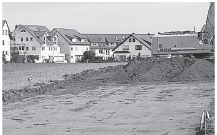
Zunächst wurde im Zuge der Erschließung im Bereich der künftigen Verkehrsflächen des Baugebietes der wertvolle Oberboden sorgsam abgetragen und in Abstimmung mit dem Landratsamt Böblingen auf landwirtschaftliche Flächen aufgebracht. Die Maßnahme wird der Gemeinde als naturschutzrechtliche Ausgleichsmaßnahme angerechnet, daher hat das Landratsamt Böblingen die Auswahl der Flächen mitbestimmt.
