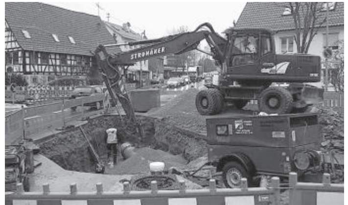
Zur Herstellung des Anschlusses an den Regenwasserkanal musste die Holzgerlinger Straße im Bereich der Schulstraße halbseitig gesperrt werden.
