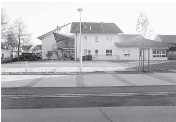
Nach der Fertigstellung – der Parkplatz sorgt für eine deutliche Verbesserung der gesamten Parksituation im Bereich der Schule und der Festhalle.
