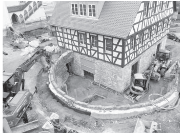
Arbeiten am Tiefhofbereich - die Natursteinmauer mit hinterfülltem Beton war im Dezember nahezu fertig gestellt.
