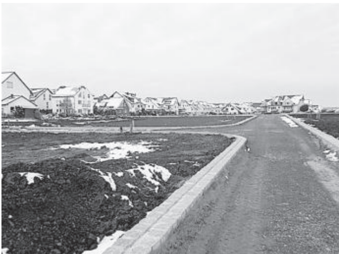
Das Baugebiet im Ende Oktober – der Straßenunterbau ist weitgehend fertig gestellt und das Granitpflaster gesetzt
