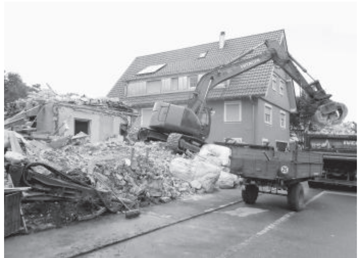
Bei den Abbrucharbeiten.
