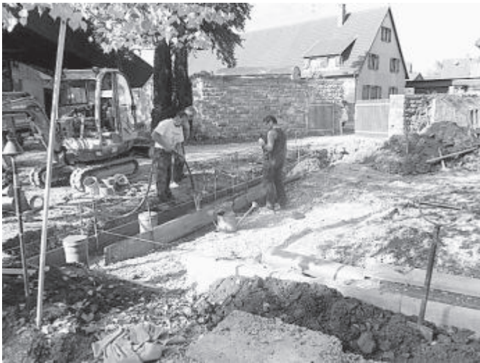
Der mittlere Bauabschnitt im Oktober.
