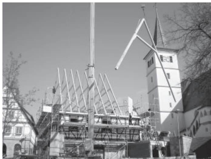
Ende März wurden die neuen Dachsparren auf dem Kirchplatz vorbereitet und der Dachstuhl aufgerichtet.
