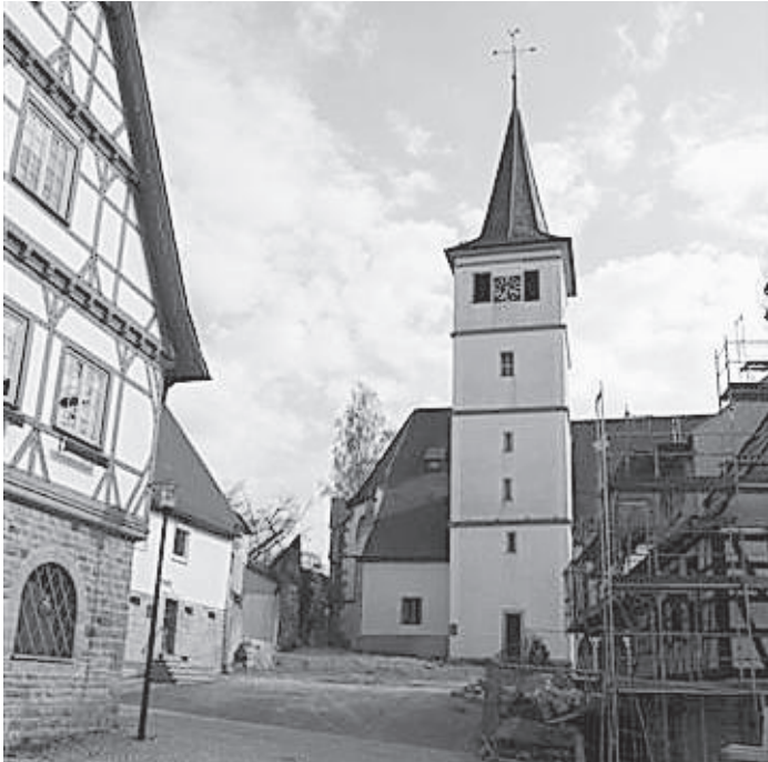
Der Kirchplatz nach dem Abbruch.
