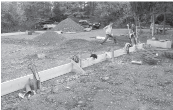
Auch die Schalung für die Bodenplatte wurde komplett in Eigenleistung gestellt.
