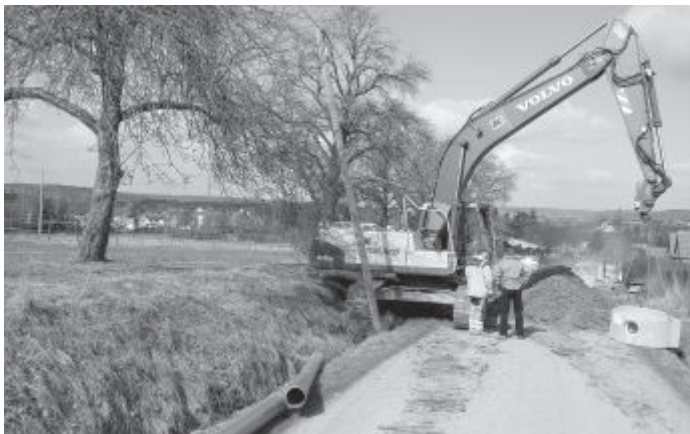
Bauarbeiten in vollem Gange
