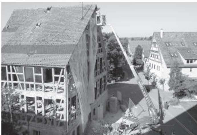
Bauhofleiter Jörg Bürglin beim Anbringen der Schutzfolie am Alten Schulhaus
