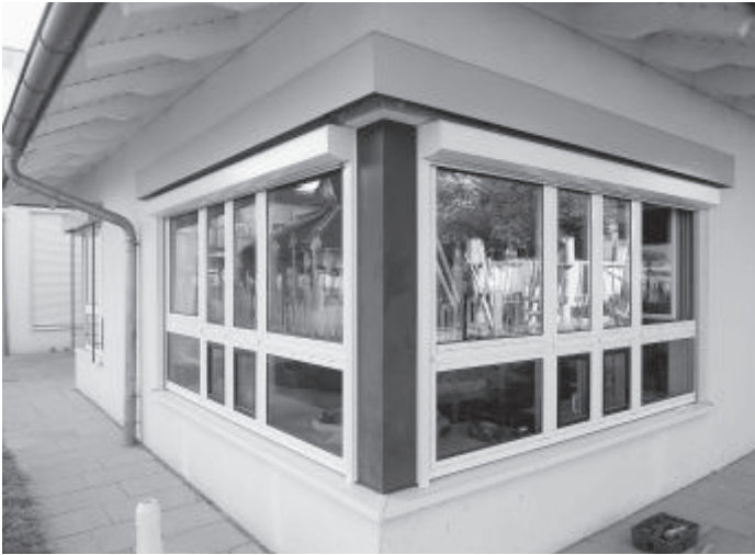
Blick auf die neuen Jalousien des Kindergartens Bühelstraße.
