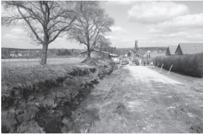
Der neue Kanal verläuft neben der vorhandenen Straße
