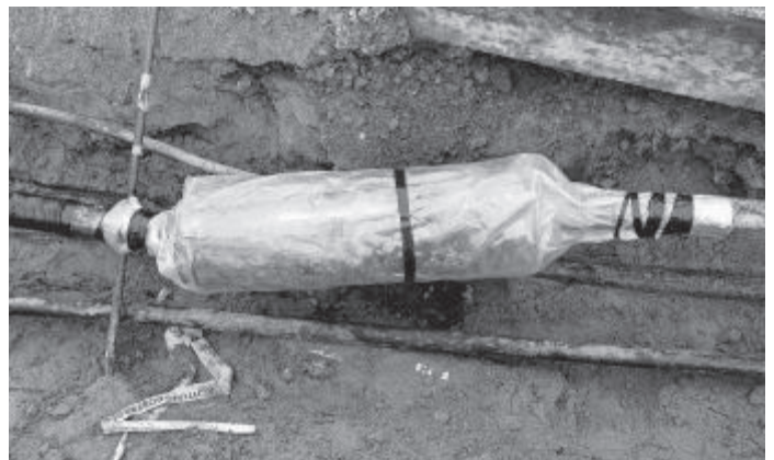
Die Fachleute bei der Behebung der Leitungsstörung unseres Telefonnetzes Foto: Volker Winkler
