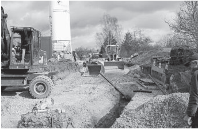
Erschließungsarbeiten, hier: Leitungsgaben
