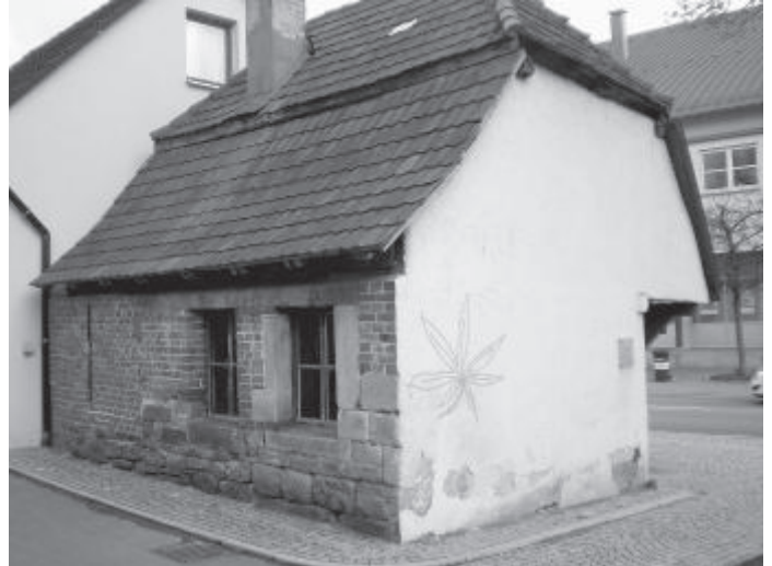
Das Backhäuschen in der Holzgerlinger Straße vor der Sanierung...
