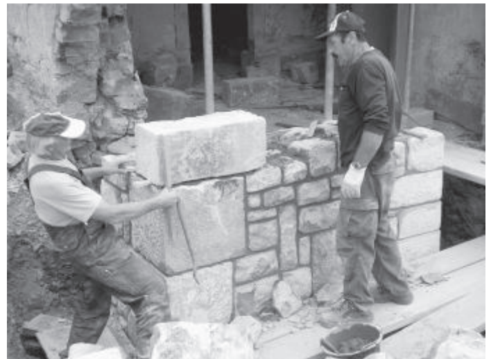
Mit fachkundigem Blick suchen die Maurer den passenden Stein aus und setzen diesen an die richtige Stelle.
