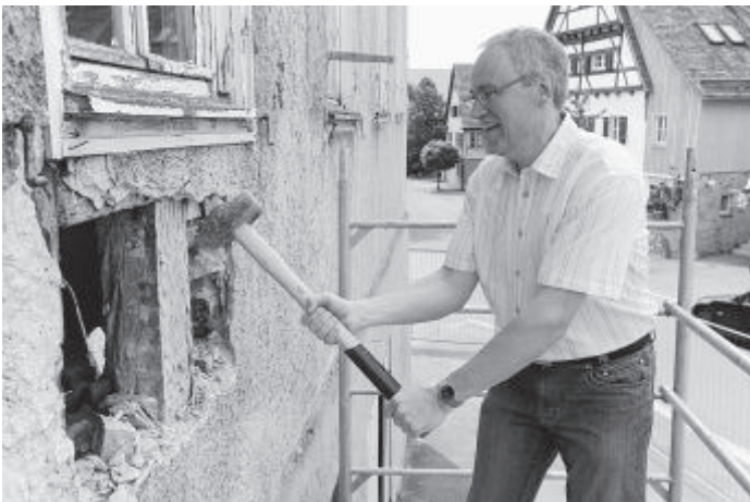
Mit den ersten Hammerschlägen läutete der Schultes den Baubeginn symbolisch ein Foto: Volker Winkler
