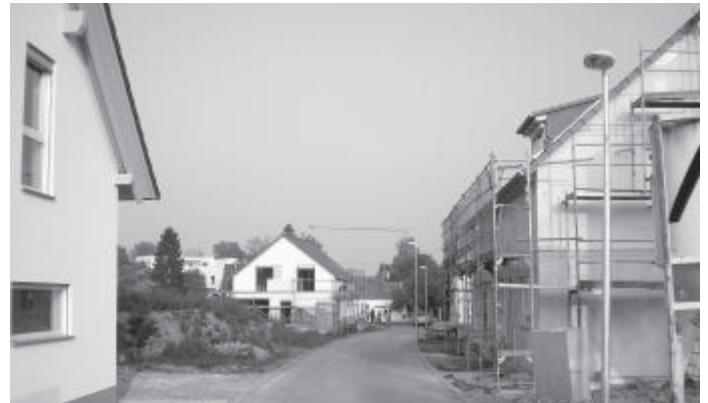
Im Oktober waren einige Häuser im neuen Baugebiet bereits bezogen, andere standen im Rohbau da.
