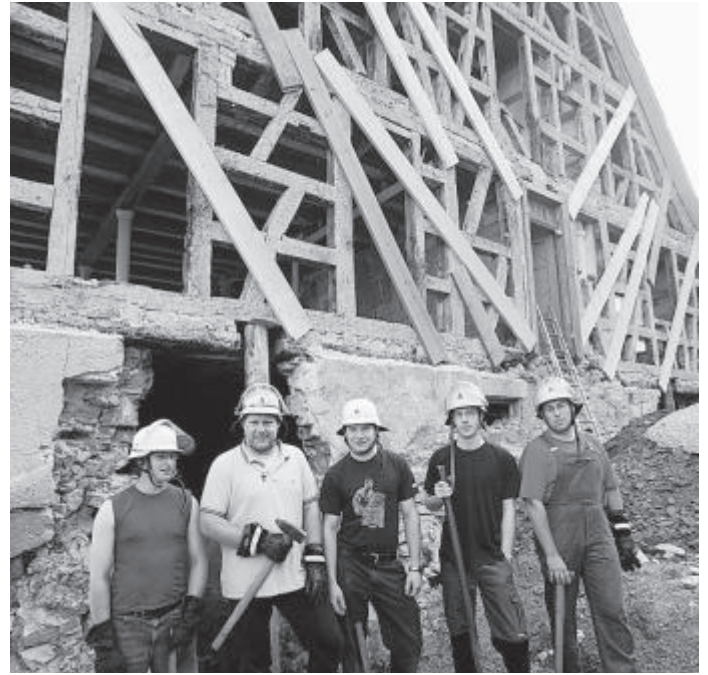
Zunächst wurden die alten Wände und das Fachwerk abgetragen.
