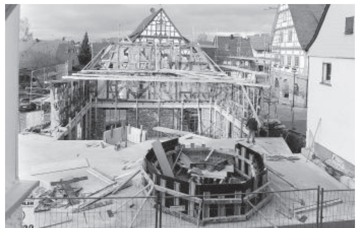
Die Baustelle zum Ende des Jahres.
