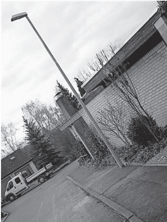
Einer der neu gesetzten Stahlmasten für die Straßenbeleuchtung
