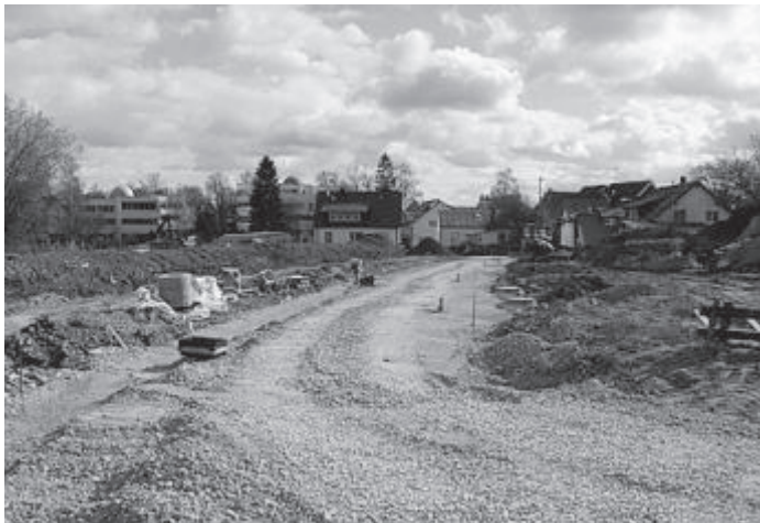
Erste Tragschicht der neuen Straße
