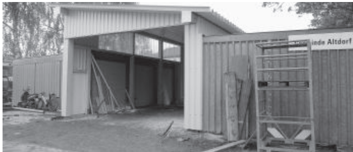
Der Platz zwischen den Garagen wurden überdacht, so dass eine neue Halle entstand
