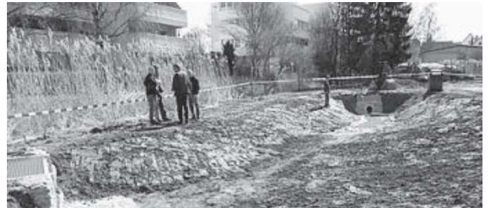
Das Retentionsbecken an der Würm, hier noch im Bau.
