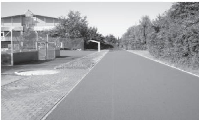
Laufbahn nach der Sanierung – hier fehlen noch die Linien, die jedoch nach dem Aushärten des Kunststoffes gleich aufgebracht wurden.
