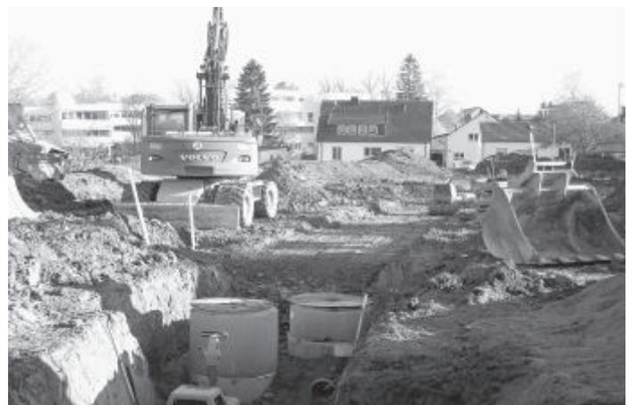
Ende November war bereits ein gutes Stück der beiden Kanäle (Regenwasser- und Schmutzwasserkanal) verlegt
