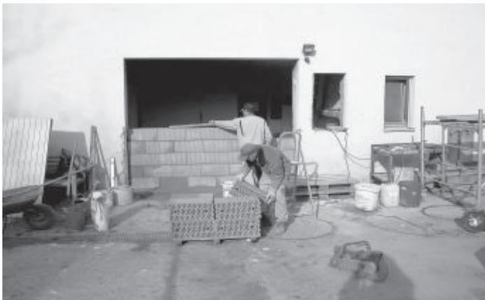
Das ehemalige Werkstatttor wurde zugemauert. In den dahinterliegenden Räumlichkeiten wurde ein neuer Sanitärtrakt mit Umkleidespinden und Waschmöglichkeiten eingebaut.
