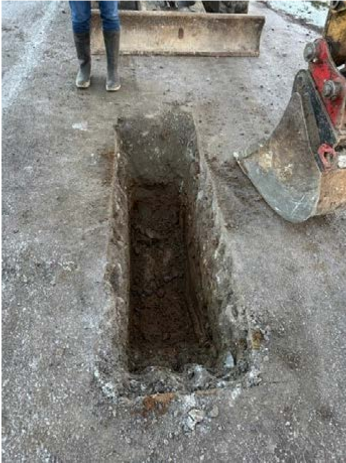
Probeschürfung am Rollerweg
