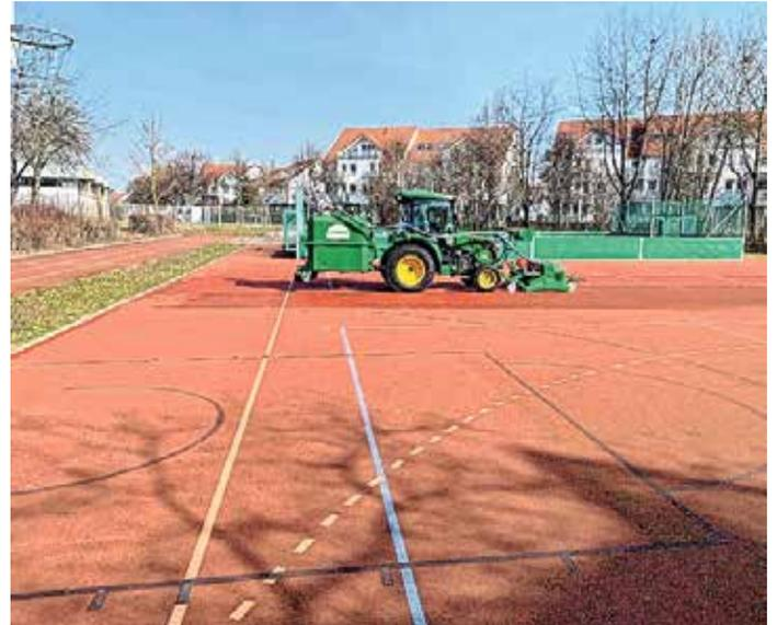
Die beauftragte Firma Polytan hat an insgesamt drei Tagen den roten Belag rund um das Minispielfeld sowie die beiden Laufbahnen mit einem Hochdruckgerät gereinigt. Die einzelnen Risse und kleinere Beschädigungen wurden anschließend behoben bzw. instandgesetzt.
