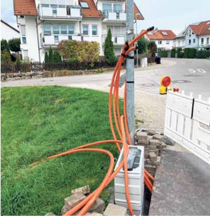
Die Telekom hat dann im September mit den Tiefbauarbeiten für den Glasfaserausbau in Altdorf begonnen. Der Ausbau umfasst über 2.000 Haushalte, die nun die Möglichkeit auf Gigabitanschlüsse erhalten. Damit wird Altdorf zu fast 100% mit Glasfaser versorgt. Dafür wird das Unternehmen in den kommenden Monaten insgesamt über 135 Kilometer Glasfaserkabel in die Erde bringen und 24 Verteilerkästen neu errichten.
