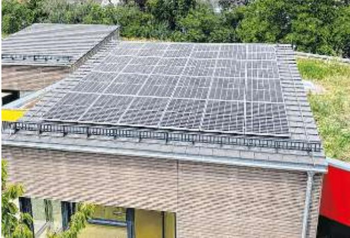
Der Eigenverbrauch durch die neue PV-Anlage mit Stromspeicher liegt bei 79 % des gesamten Stromverbrauchs für das im Jahr 2018 in Betrieb genommene Kleinkindhaus mit 3 Gruppen. Somit ist eine optimale Ausnutzung der Eigenstromproduktion mit Stromspeicher gewährleistet. Der Stromüberschuss aus der PV-Anlage wandert tagsüber direkt in den (Akku) Stromspeicher zur späteren Eigennutzung.
