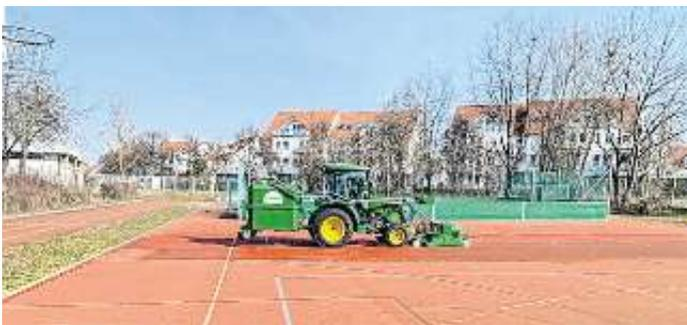
Die beauftragte Firma Sandmaster hat an insgesamt drei Tagen den roten Belag rund um das Minispielfeld sowie die beiden Laufbahnen mit einem Hochdruckgerät gereinigt. Die einzelnen Risse und kleinere Beschädigungen wurden anschließend behoben bzw. instand gesetzt.
