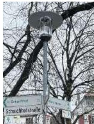
Im Januar 2021 wurde bereits die Beleuchtung an der Ortsdurchfahrt von bisher 150 Watt Leistung (Natriumdampfleuchten und Quecksilberdampfleuchten) auf LED, mit einer Leistung von 55 bis 83 Watt umgestellt. Durch die Umstellung auf LED wird bei nahezu identischer Lichtausbeute (100-150 lm/W) deutlich weniger Strom aufgewendet.
