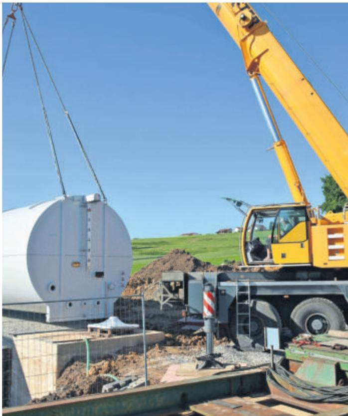
Im Juni wurde der neue Gasbehälter mit einem fast 30 m langen Schwerlasttransporter mit einem Gesamtgewicht von über 60 Tonnen angeliefert. Mit Hilfe eines Kranwagens wurde der Behälter auf die vorbereiteten Sockel gestellt.
