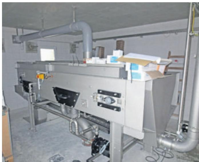
*Die neuinstallierte Anlage zur Vorentwässerung des Klärschlammes*
