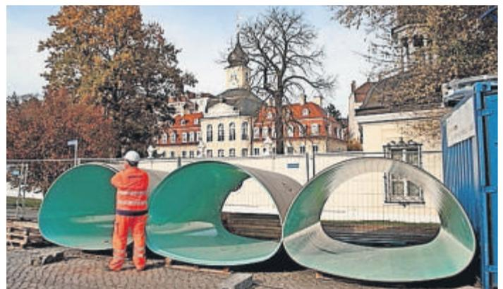
Außerdem sollen Teilstrecken mit einem sogenannten Maulprofil ausgeführt werden, ein zu beiden Seiten hin breitgequetschtes O, sodass das erforderliche Höhenprofil besser eingehalten werden kann.
