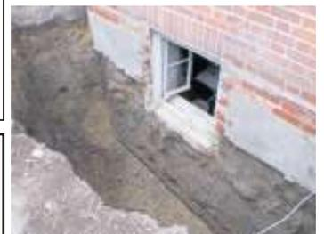
Oft problematisch ist die Abdichtung der Kellerwände. Ist sie überhaupt vorhanden? Und wenn ja, müssen Abdichtung und Drainage erneuert werden?
