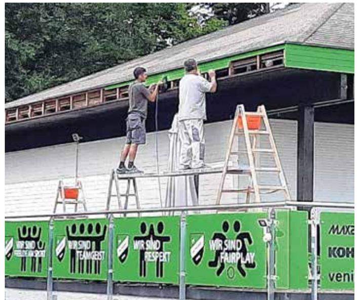
Montage der neuen Holzverkleidung an der Dachkante
