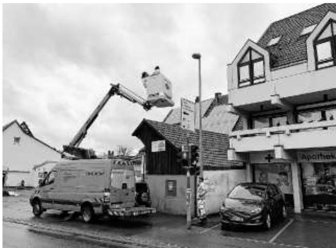
Durch die Umstellung auf LED wird bei nahezu identischer Lichtausbeute (100-150 lm/W) deutlich weniger Strom aufgewendet.
