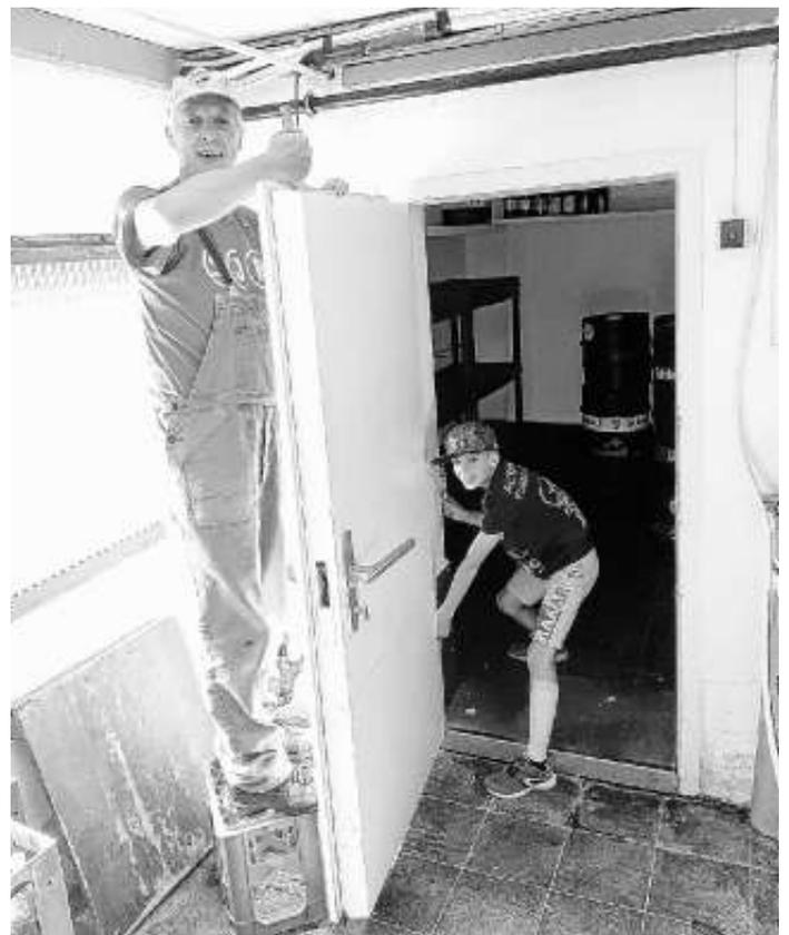
Jan Frohnmüller und Felix Hornisch entfernen poröse Gummidichtungen im Kühlraum
