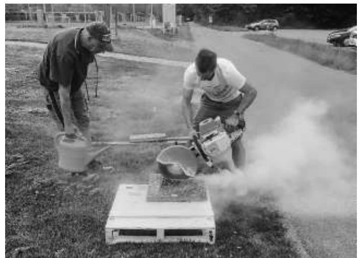
Zusägen der Waschbetonplatten
